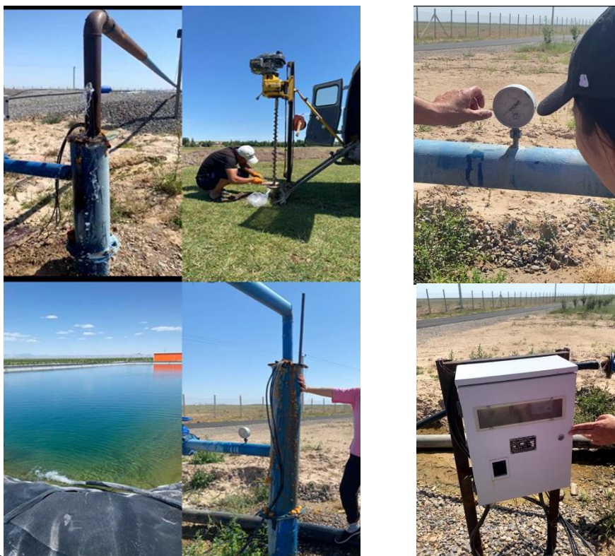
Рисунок 8 – Бурение скважин и проведение из них откачек подземных вод (фотографии сделаны во время прохождения производственной практики)
